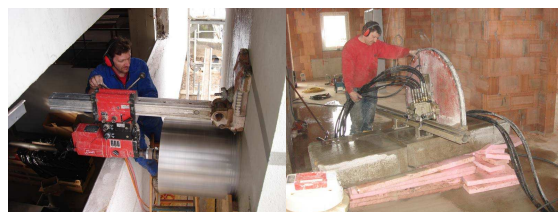
Kernbohren/ Betonschnitte
